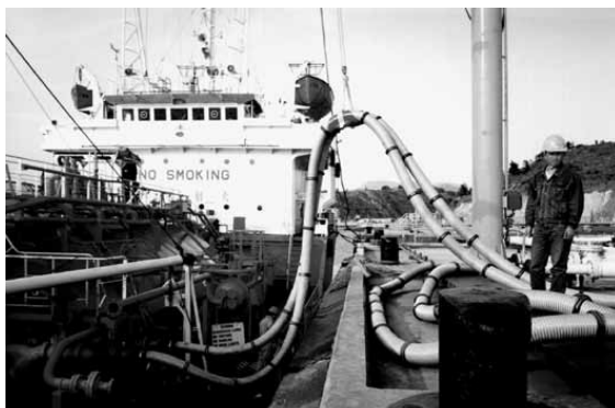
Рисунок 2. Композитные напорно-всасывающие рукава для нефтепродуктов
